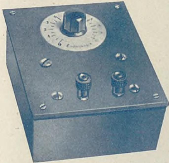
Aquest aparell permet obtenir una corrent finament regulable entre 0 i 15 Volts, el més adequat per el mirall segamm Clas, cistescops, rectescops, etc., ambé dispositat per ésser connectat a una corrent alterna de 125 Volts.
