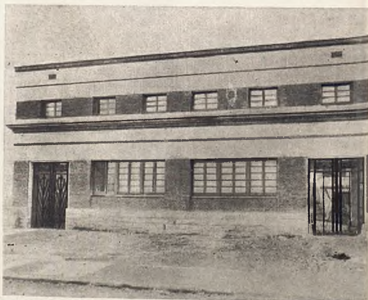
Façana dels Dispensaris i entrada a la Clínica
