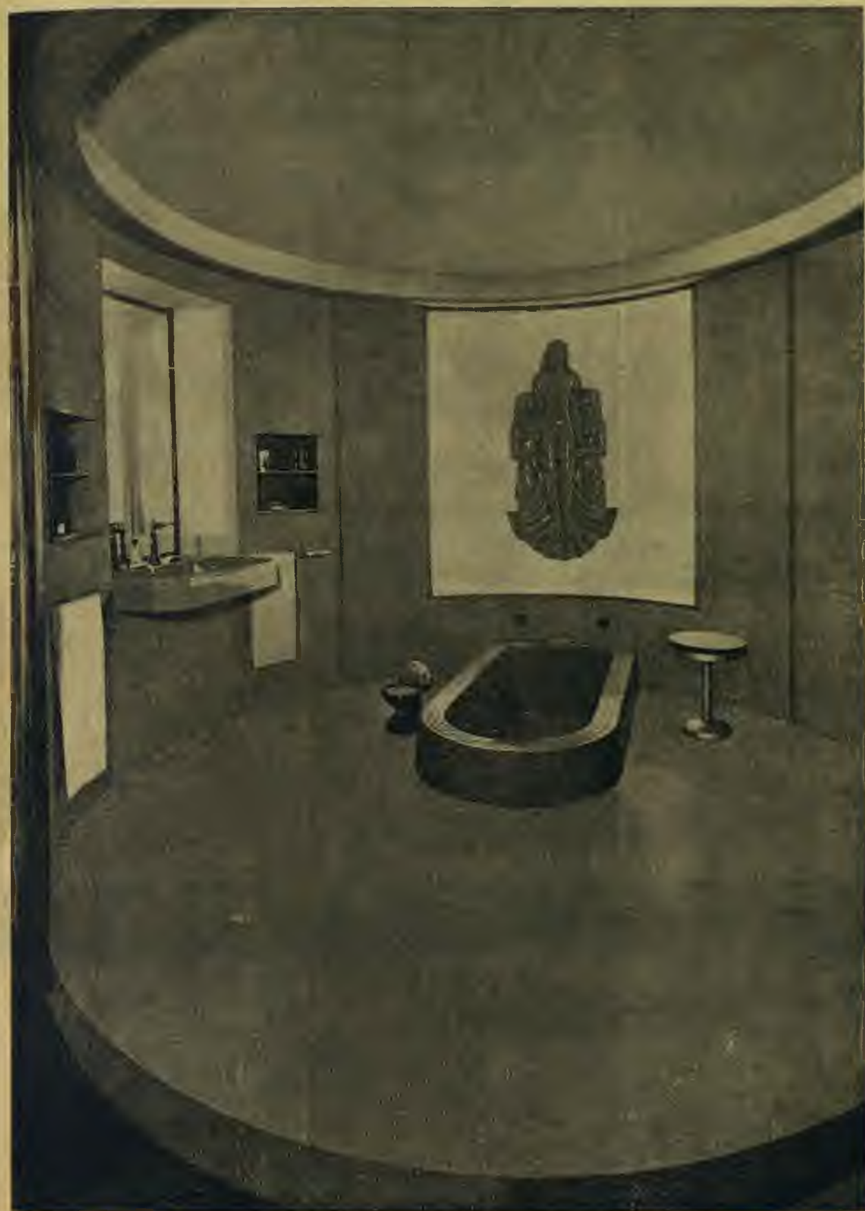
PAVIMENT DE GOMA PIRELLI
