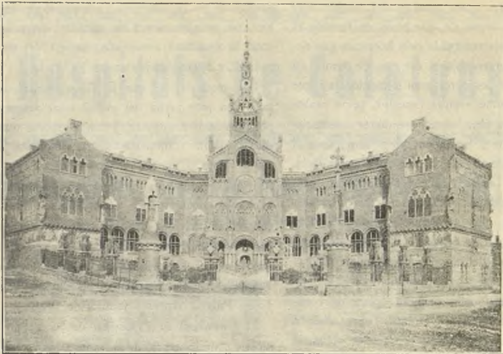
Edifici d'Administració. Vista general.
