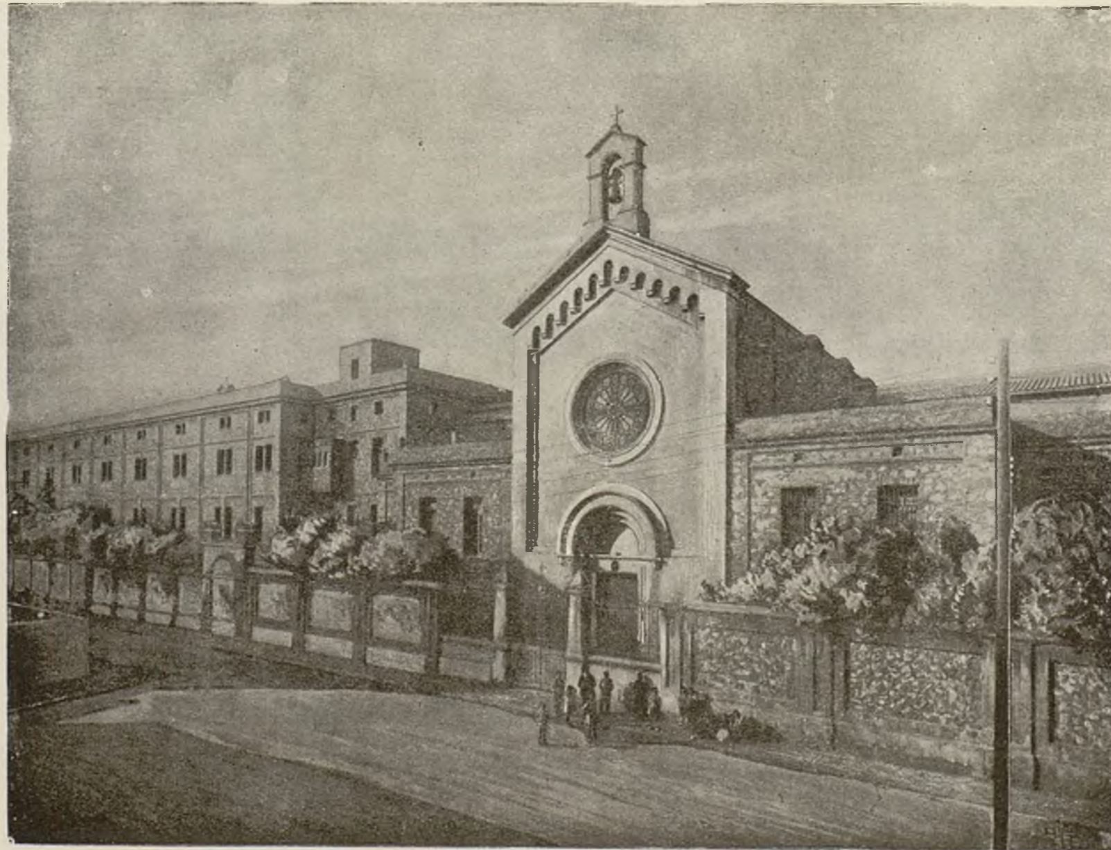
Vista parcial de la façana
