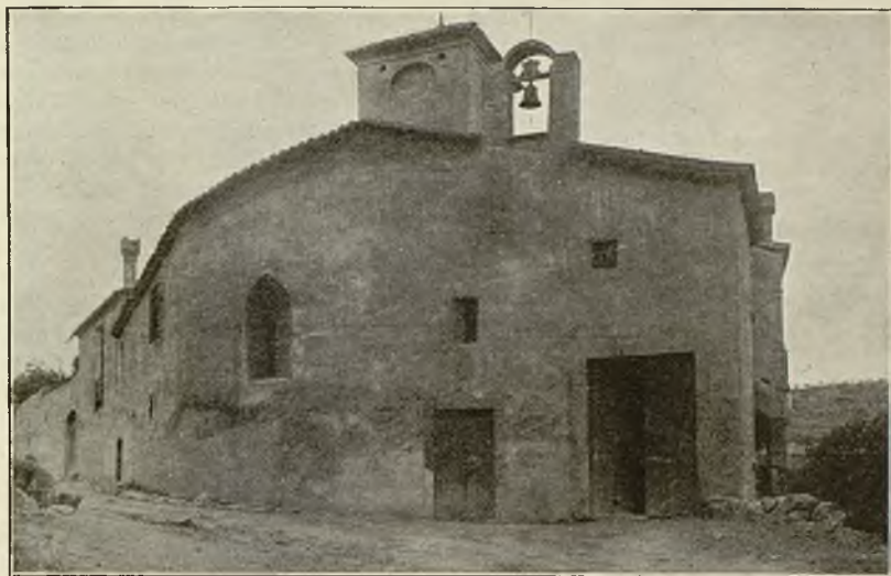
Edifici on hi havia l'Hospital de Sant Pau
